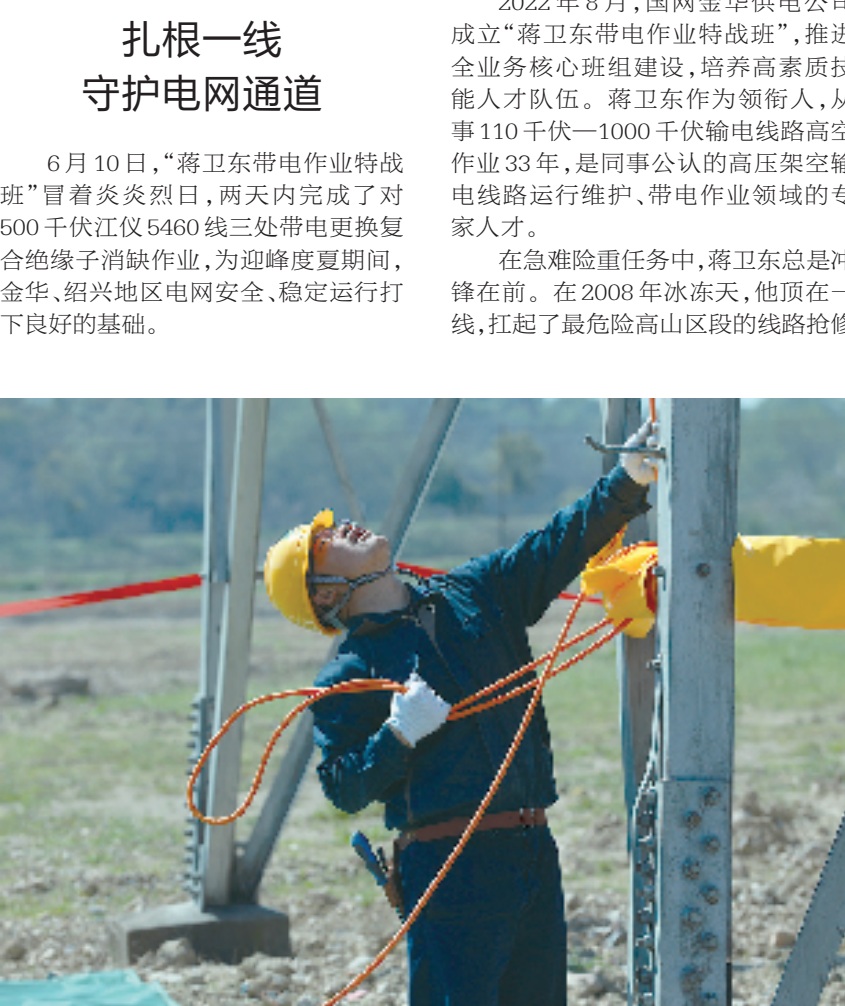
今年3月，国网金华供电公司“蒋卫东带电作业特战队”正在500千伏双兰线开展带电更换绝缘子作业，蒋卫东在塔下协助工作。 张守成 摄
