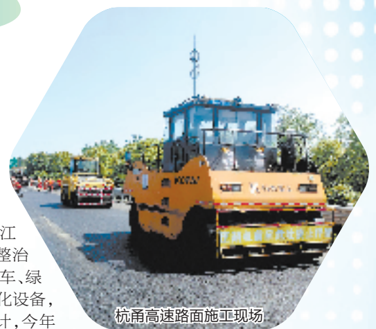
杭甬高速路面施工现场
