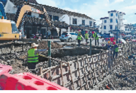
7月26日,杭州市富阳区受灾乡镇的干部群众赶在台风“杜苏芮”带来不利影响前,抓紧时间修复河堤。图为富阳区交通集团抢险队在上官乡抢修堤坝。
