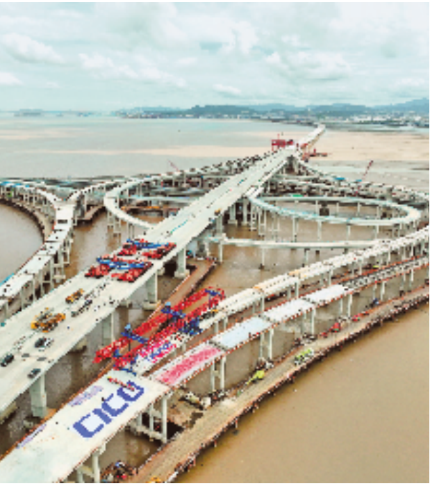
图为7月25日下午,杭甬复线宁波一期项目滨海互通的施工现场。 拍友 姚峰 施雷雷 摄
