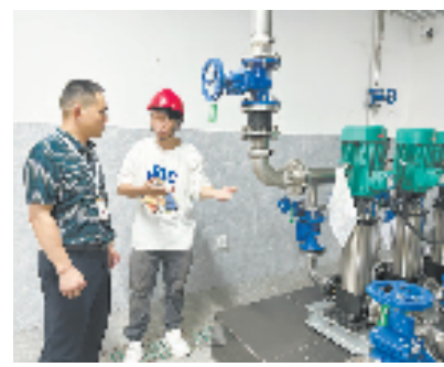
余杭区中泰街道社区监察联络站成员调研小区供水设备。(图片由余杭区中泰街道提供)
