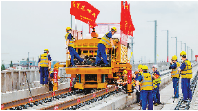
7月20日，在杭温高铁位于义乌市香山村隧道出口施工现场，首对500米长钢轨被平稳地铺设在无砟轨道板上，标志着杭温高铁进入全线铺轨阶段。 共享联盟·金华 胡云飞 摄（相关报道详见第二版）
