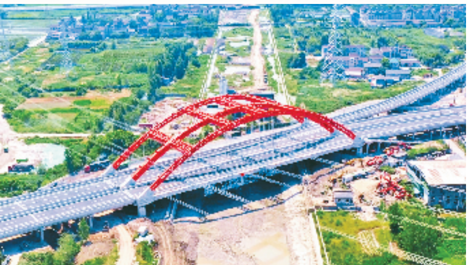
2022年11月8日,320国道桥完工。
