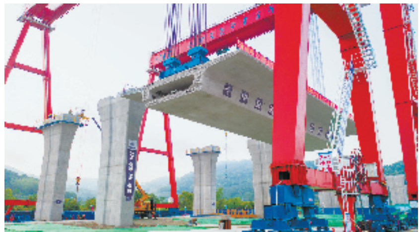
建设中的象山湾疏港高速 宁波象山湾疏港一期高速公路有限公司供图
