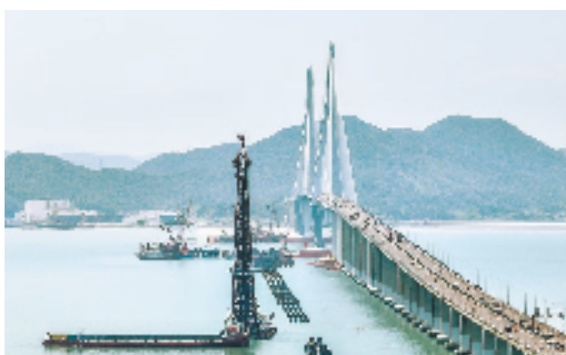
当前,宁波至象山海域(郊)铁路工程象山港跨海大桥正在火热建设中。目前,南岸已进入全栈桥施工,南侧主墩桩基已顺利开钻,北岸的施工栈桥正在抓紧搭建,整个项目正稳步推进。 拍友 姚峰
