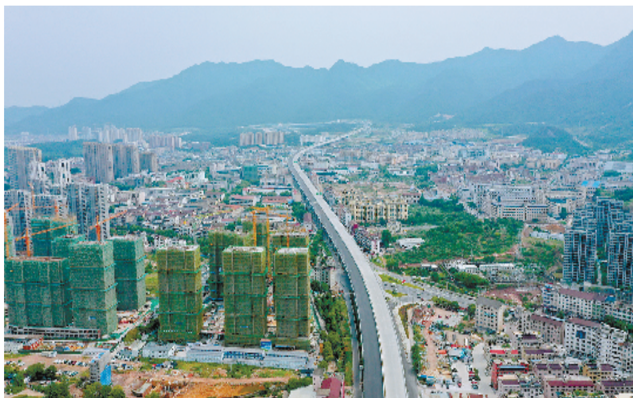
正在建设的义东高速
