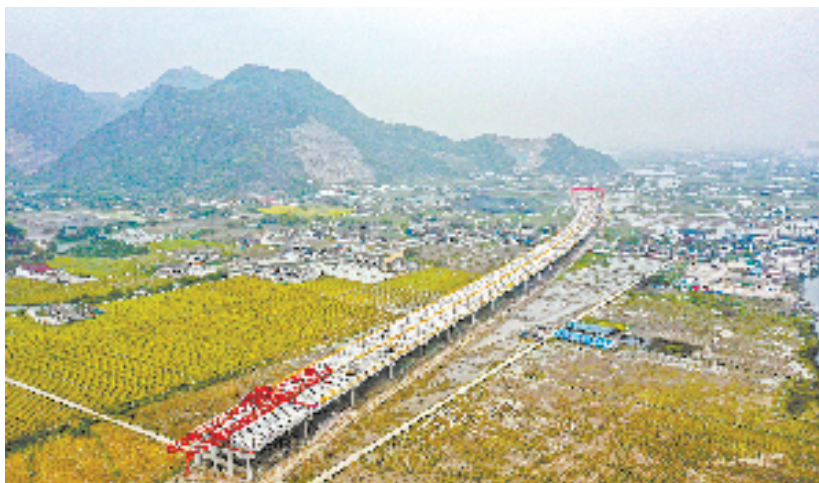
正在建设的瑞苍高速
