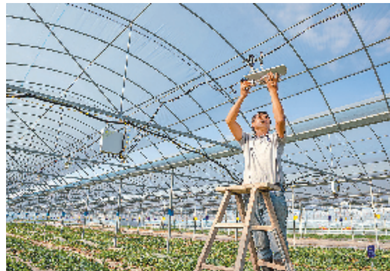
基地员工正在调试大棚内的智能补光系统。智能化管理,让甜瓜大棚尽显科技感。
