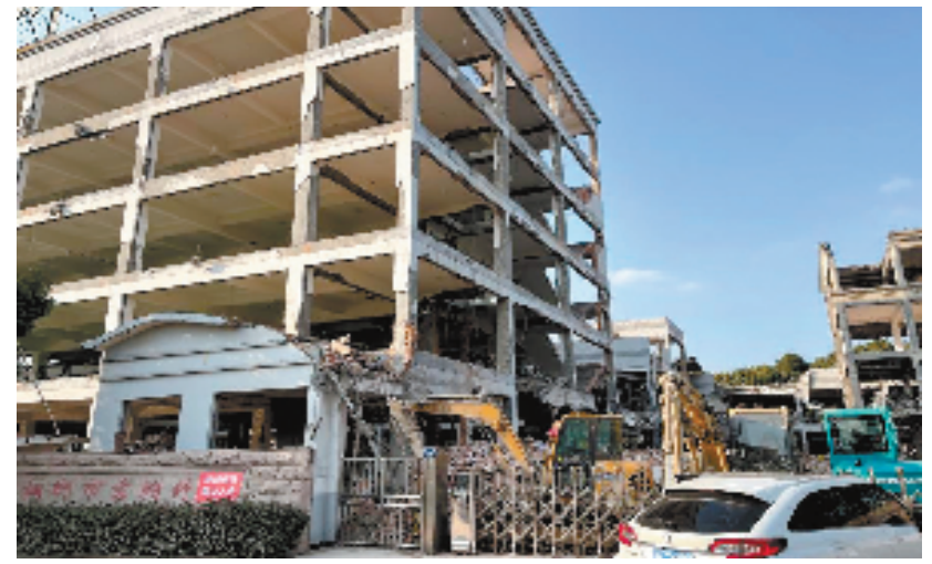
加速拆除旧厂房
