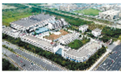
云速公司技改前
