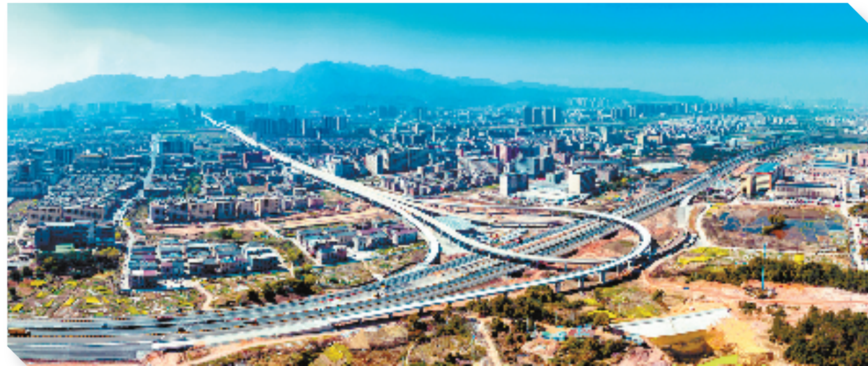
建设中的义东高速
