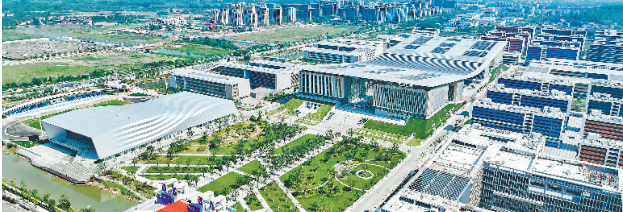
北航中法航空学院航拍图
