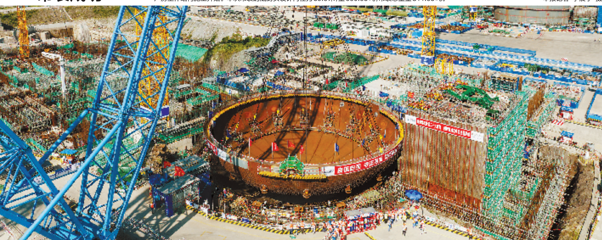
5月29日上午,三门核电二期工程4号机组核岛钢制安全壳底封头顺利吊装就位。这是该工程4号机组核岛反应堆厂房吊装的首个大型模块,标志着该厂房主体结构施工开始。本次吊装的底封头设计内径为39.6米,重660.65吨,吊装总重量811.65吨。 本报记者 李震宇 摄
