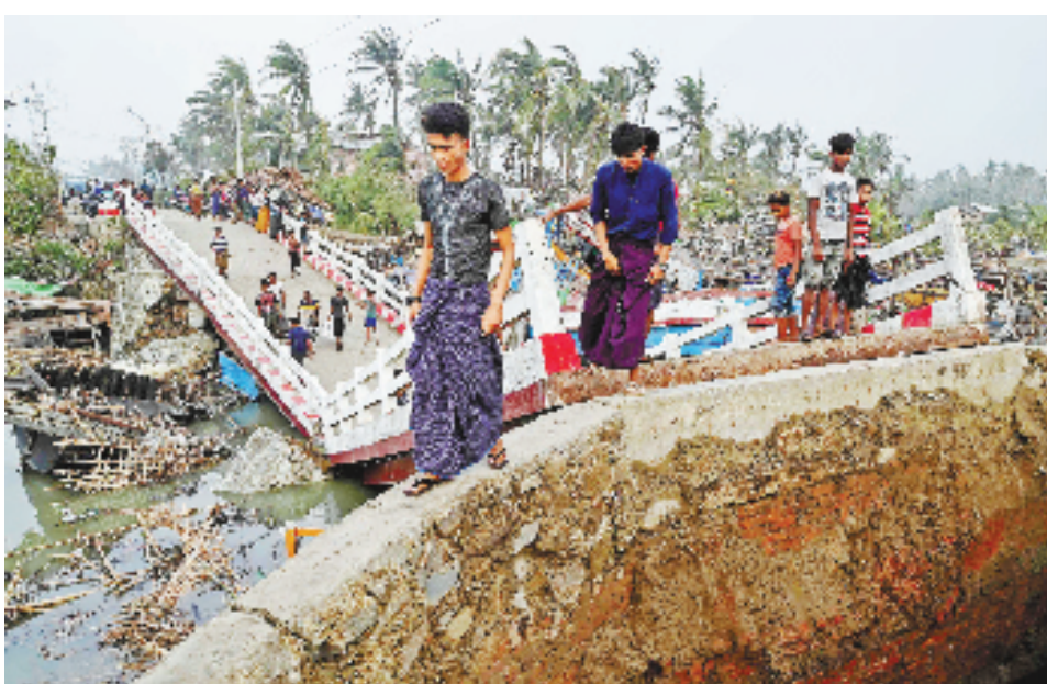
5月14日登陆缅甸的热带气旋“穆查”已造成上百人死亡,多地受灾。图为缅甸若开邦实兑居民经过受损的桥梁。
