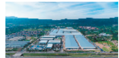
比亚迪新能源动力电池生产基地项目一期 (嵊州经济开发区(高新园区)供图)
