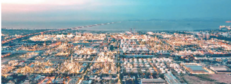
建设中的镇海基地二期项目
