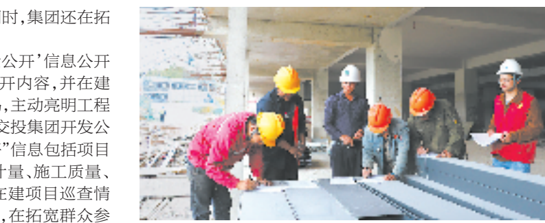
建筑工人现场填写“廉洁指数”测评表 吴行芳 摄
