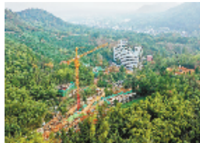
山屿海浪漫谷项目建设现场，机械轰鸣、车辆穿梭，一派热火朝天景象。张卉 摄
