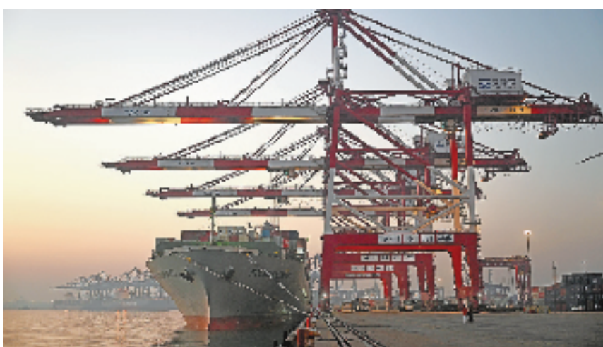
一艘货轮靠泊在天津港联盟国际集装箱码头进行装卸作业。
