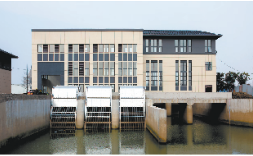
鄞江堤防整治工程——元贞闸站 (宁波市水利局供图)
