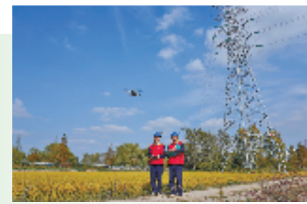
无人机巡检线路
