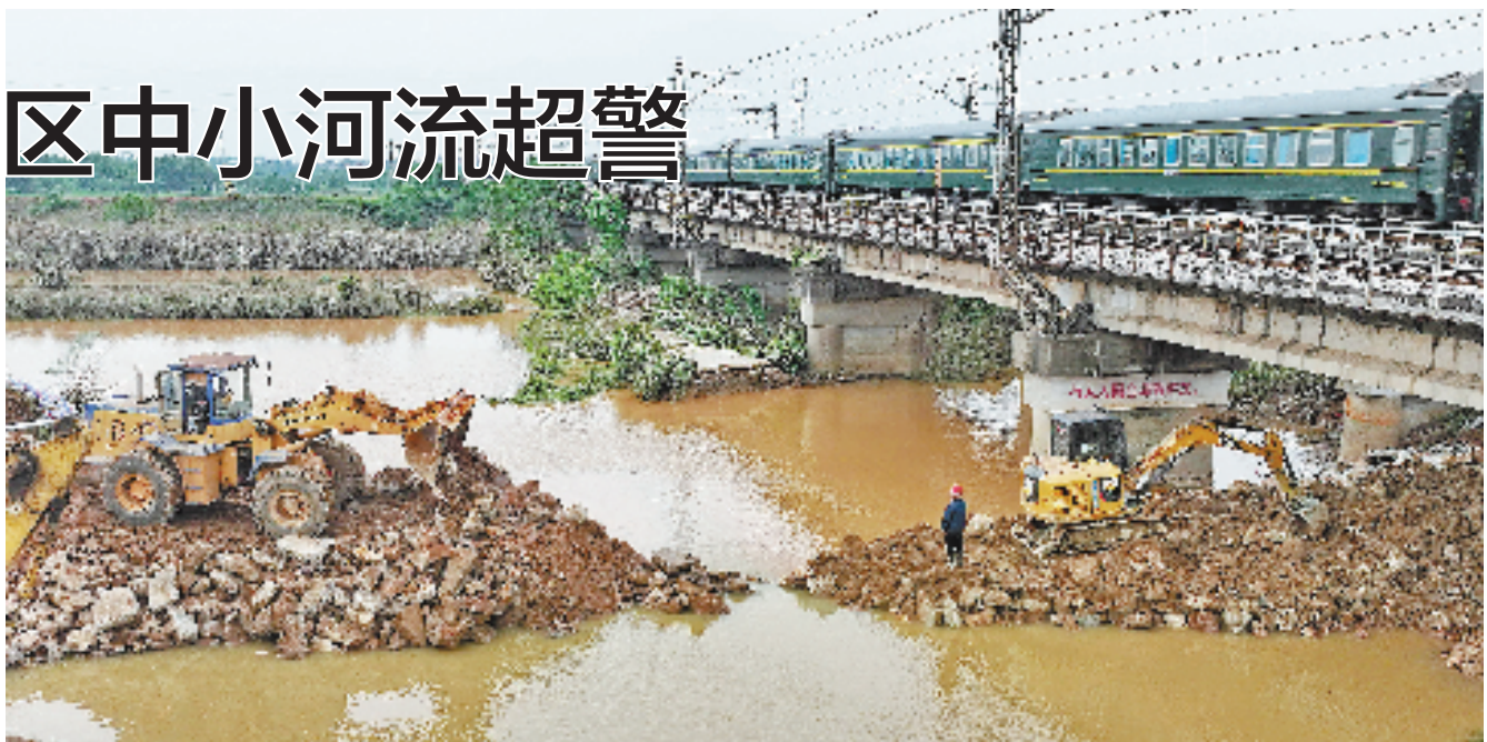
5月7日18时许,江西省丰城市京九线铁路桥下丰满堤溃口顺利封堵。在抢险人员连续奋战29小时后,近30米长的溃口成功合龙。220名被转移和安置的群众已全部安全回到家中。京九铁路安全运行。图为溃口封堵现场。新华社记者 万象 摄
