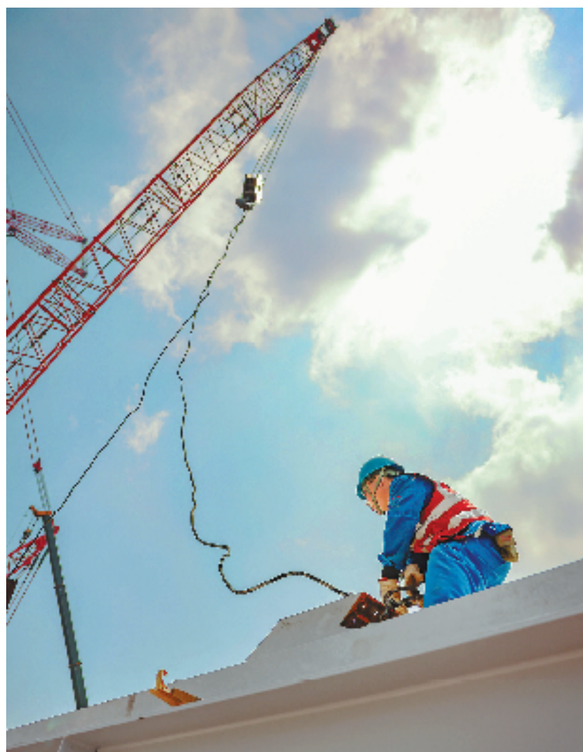
浙能六横电厂二期工程施工现场。
