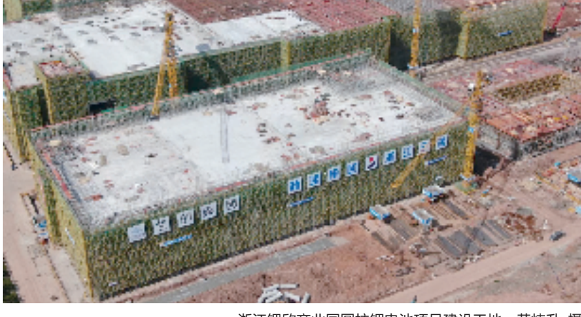
浙江锂电产业园圆柱锂电池项目建设工地 黄升开 摄
