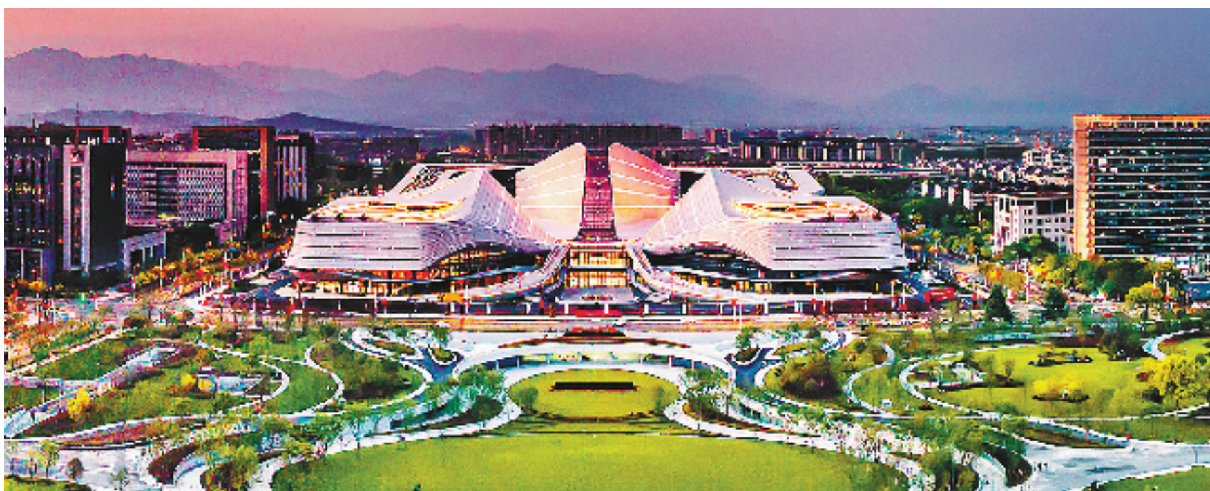
衢州市政务服务中心(文化艺术中心)航拍图。衢州市营商办供图
