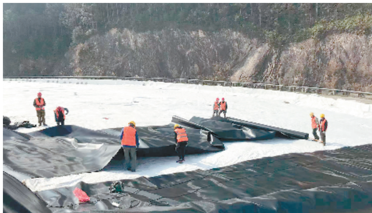
松阳垃圾填埋场地下水污染阻控工程项目施工现场
