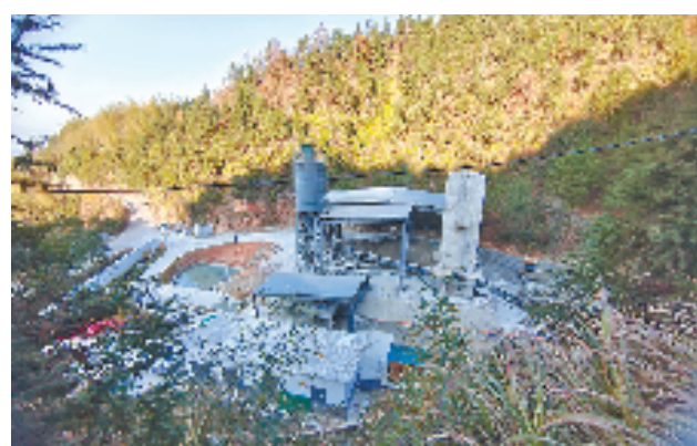
遂昌黄铁矿地下水污染治理工程一期项目充填站
