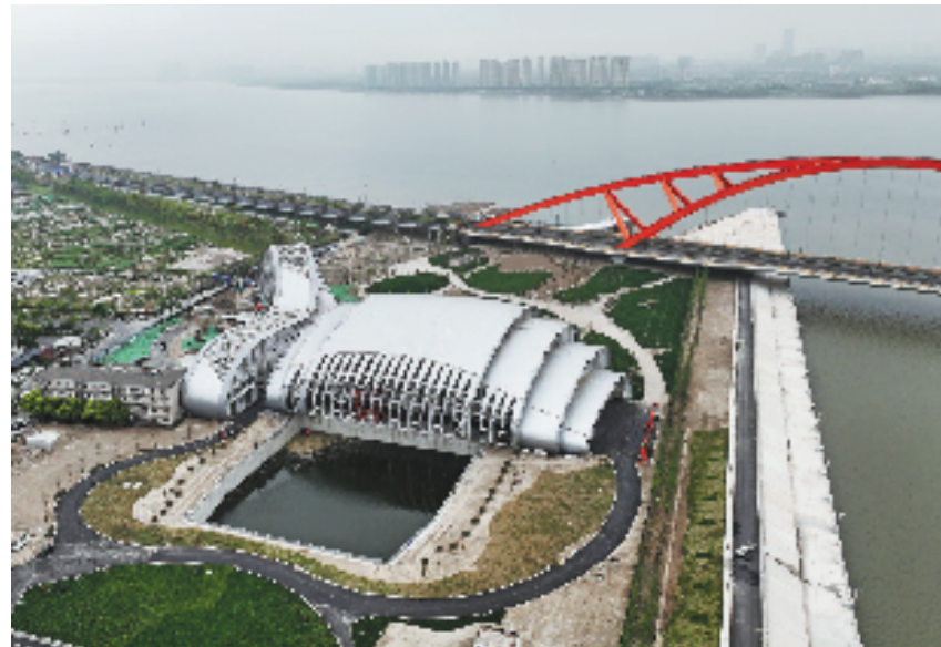
图为八堡排水泵站(右侧为运河二通道,上方为钱塘江)。
