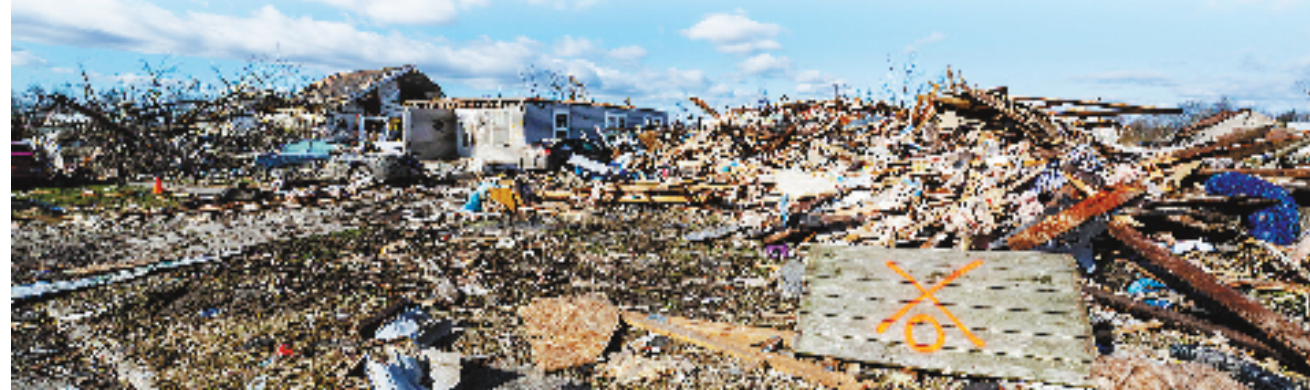
4月1日在美国印第安纳州沙利文县拍摄的极端天气过后房屋损毁的景象。
