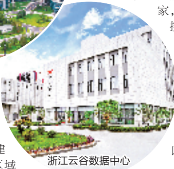
浙江云谷数据中心
