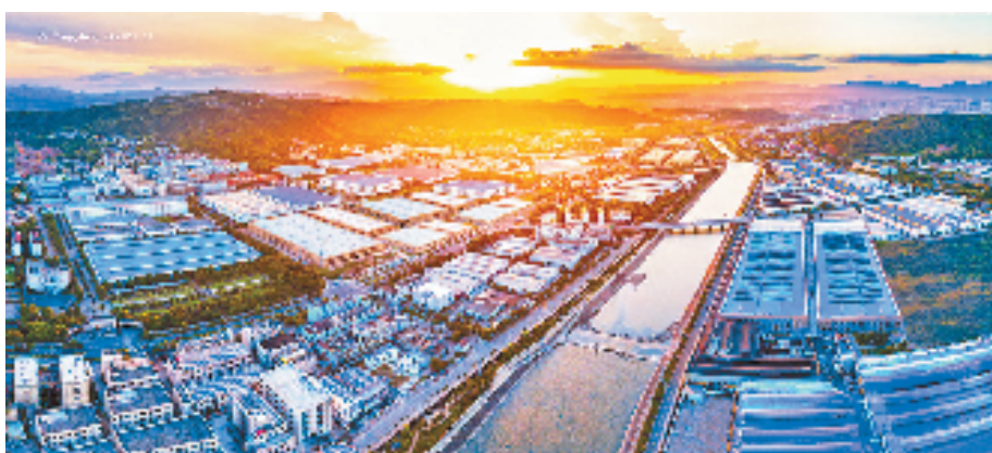
新昌县高新园区航拍图
