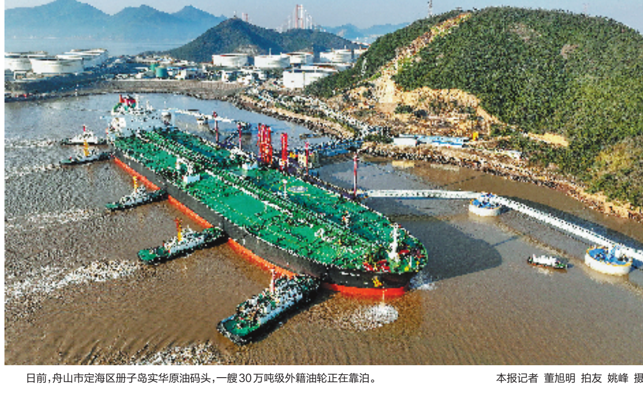
日前，舟山市定海区册子岛实华原油码头，一艘30万吨级外籍油轮正在靠泊。
