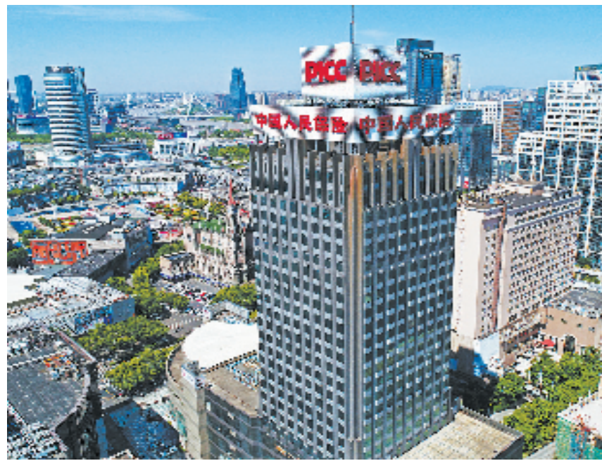
人保财险宁波市分公司大楼
