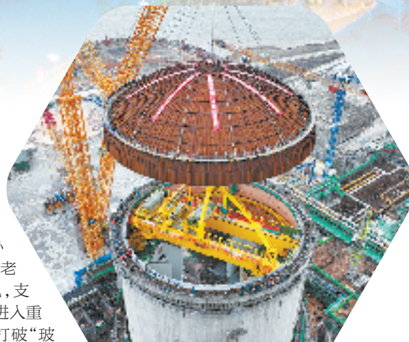
苍南的三澳核电正进行穹顶吊装
