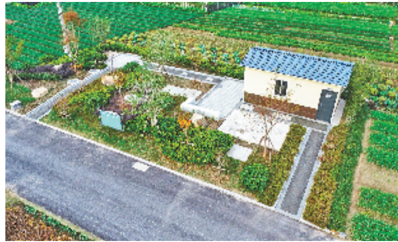
萧山区宁围街道顺坝村农污处理设施(杭州市萧山区水务建设管理服务中心供图)
