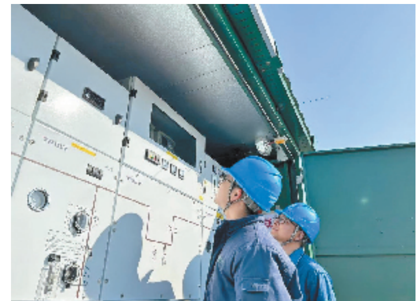
客户在现场做通电前的检查 (图片由国网杭州市钱塘区供电公司提供)
