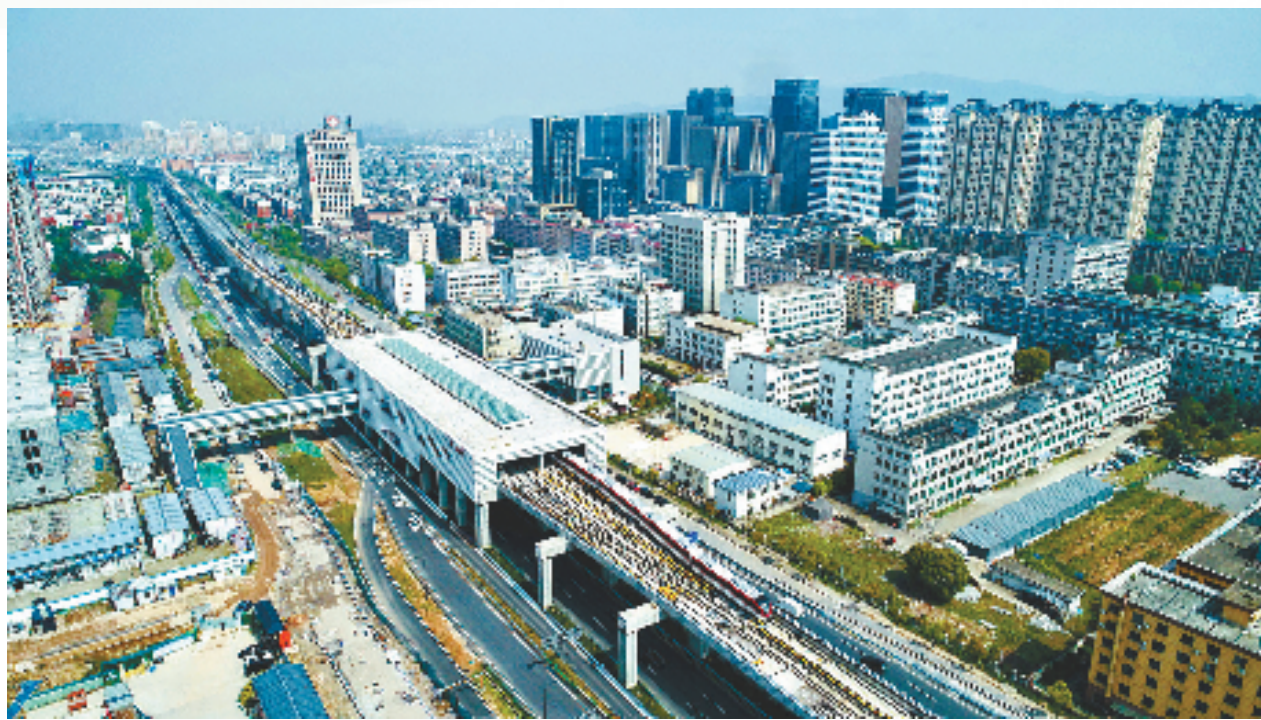
轻轨穿过稠江街道
