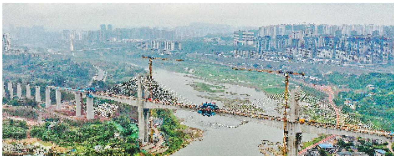
3月18日在四川省泸州市拍摄的渝昆高铁泸州沱江特大桥主跨合龙施工现场。
