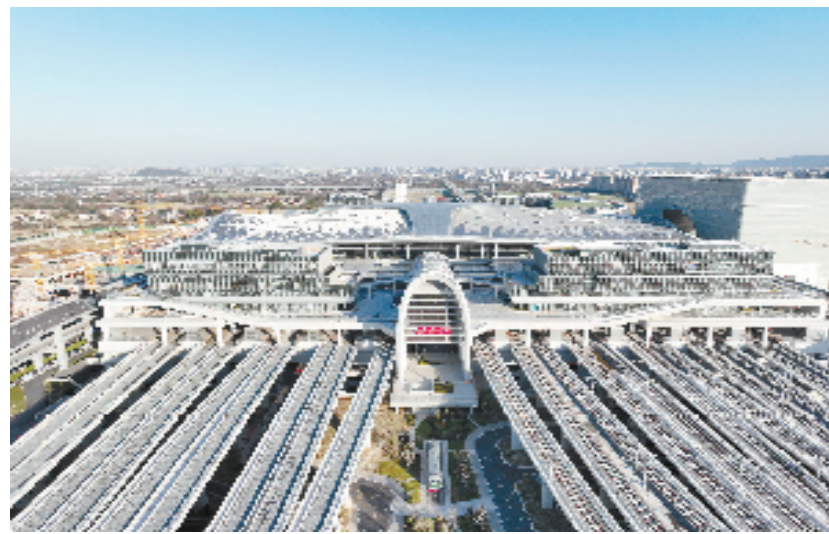
2022年9月,杭州火车西站正式启用。
