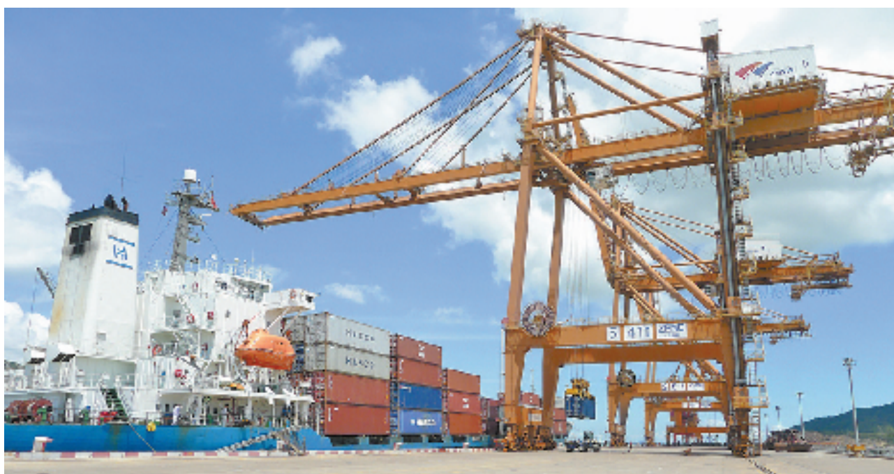
温州港状元港区生产场景
