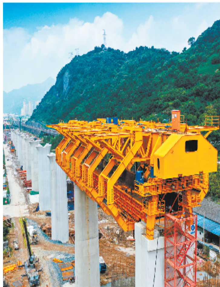
永嘉积极融入新发展格局，图为杭温高铁施工现场。
