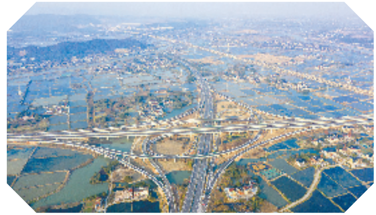
杭州绕城高速西复线 蔡俊 摄
