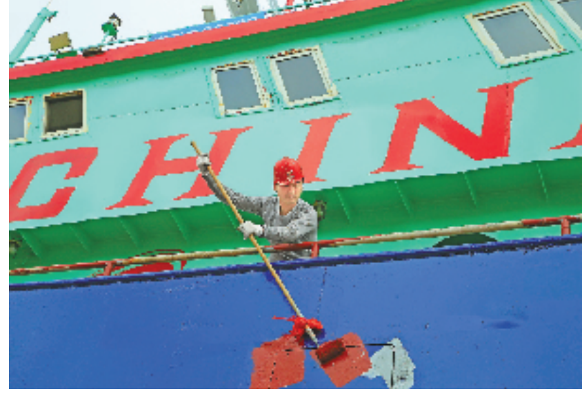
2月18日,玉环市坎门街道灯塔船舶修造厂一派忙碌景象,工人们加紧维修船只,为春季出海捕捞做准备。 拍摄 段俊利
