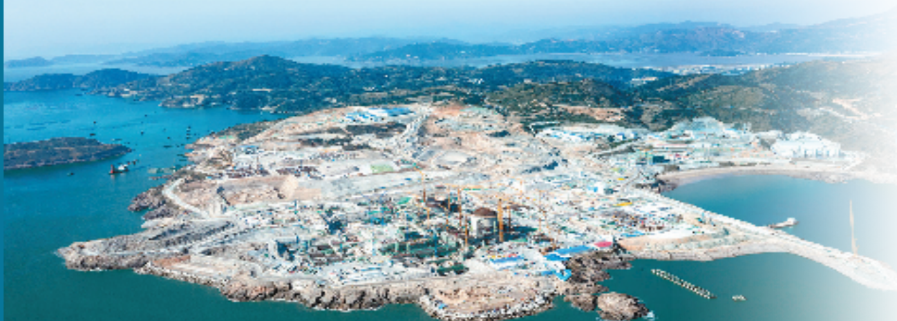
正在建设的苍南三澳核电项目鸟瞰图 中广核苍南核电公司供图
