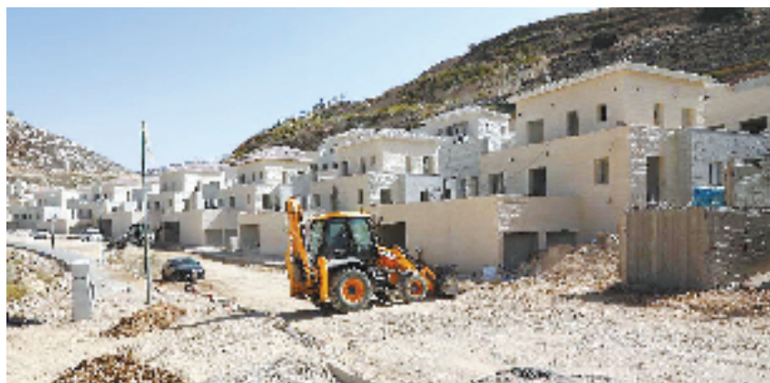
约旦河西岸犹太人定居点吉瓦特泽夫的一处房屋施工现场。
