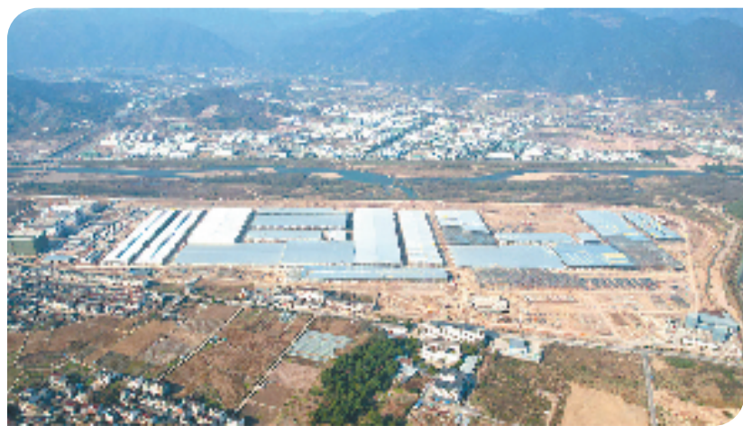
新能源厂区建设热火朝天
