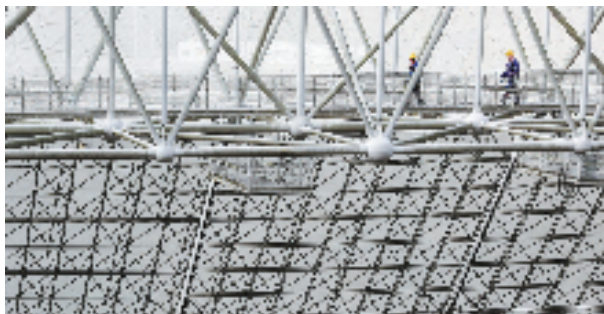
2月13日,工作人员从“中国天眼”的圈梁上经过(维护保养期间拍摄)。
