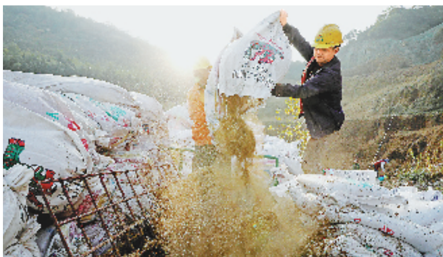
用于喷播的材料是由16种灌木等植物种子和肥料、黏合剂等配制而成,确保了山体复绿后山上植被的多样性。
