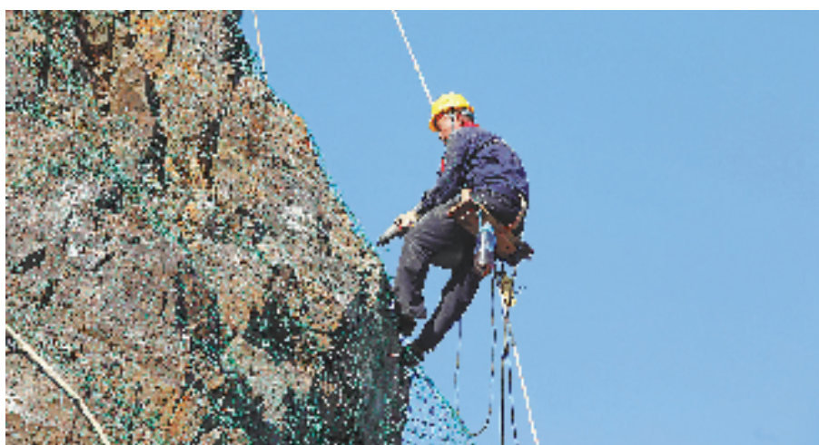
郑保钢身体几乎是悬空在岩壁上,完成铆钉加固等高难度作业。
