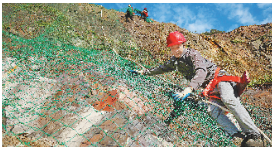
从事生态修复的工人像“蜘蛛人”一样在陡坡上小心地铺设护坡网。
