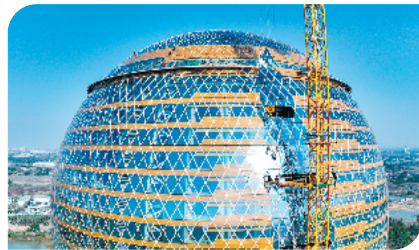
位于“上合区”的太阳酒店整体结构已完工 陆志鹏 摄
